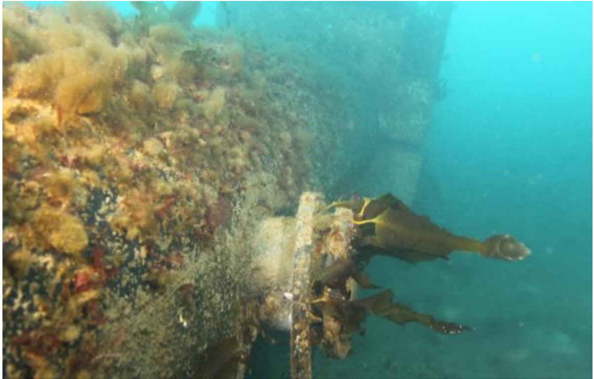
Mynd 19. Mars 2011, þörungar á efri hluta rörsins, dýr á neðri, gróður jafnvel alveg við útstreymið.
