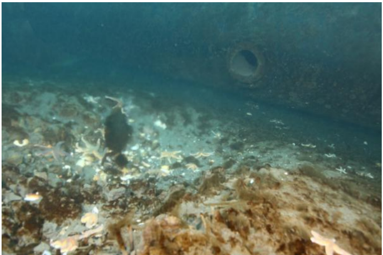
Mynd 18. Mars 2011, útblástursrör hefur myndað smá dæld í botninum þar sem mikið er af krossfiski.
