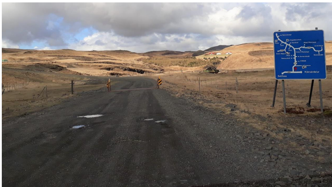
Mynd 20: Gamli vegurinn í Þjórsárdal, séð til suðurs (ljósmynd: Hjalti Jóhannesson).
