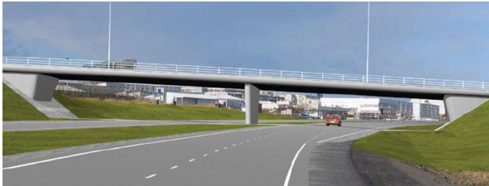
Mynd 7. Ný brú yfir Nesbraut (úrklippa út Framkvæmdafréttum).
